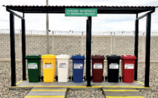
Almacén RRSS - Subestación REQUE
