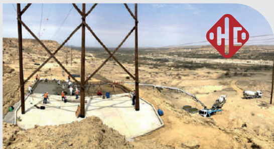
Vaciado con Bomba Telescópica Losa de Concreto Armado para protección del Poste P14
