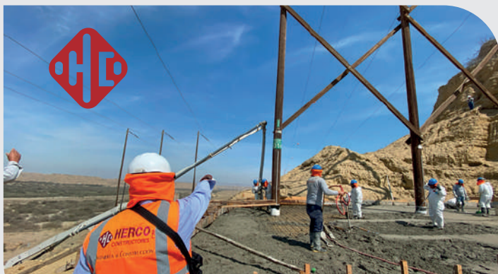
Supervisión de Vaciado de Losa de concreto Armado
