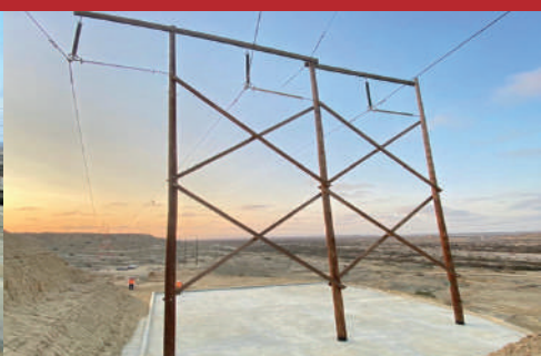
Vista Panorámica de Losa construída
